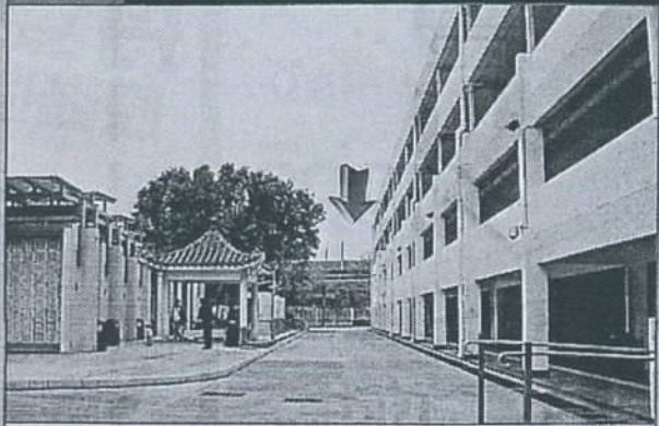
圖因應葵涌靈灰安置所加建骨灰龕位工程，食環署將葵涌紀念花園（箭嘴所示）大部分草地鋪作緊急車輛通道。
